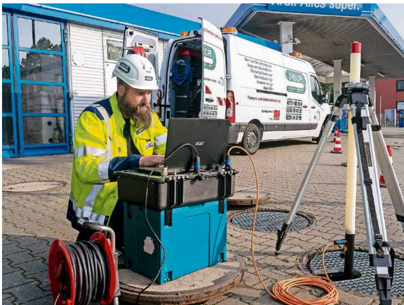
Die Generalinspektion eines Ölabscheiders gehört zu den durchaus vielfältigen Aufgaben, die eine Fachkraft für Rohr-, Kanal- und Industrieservice ausführt. Foto: Drekkopf Entsorgung und Kanalservice GmbH
